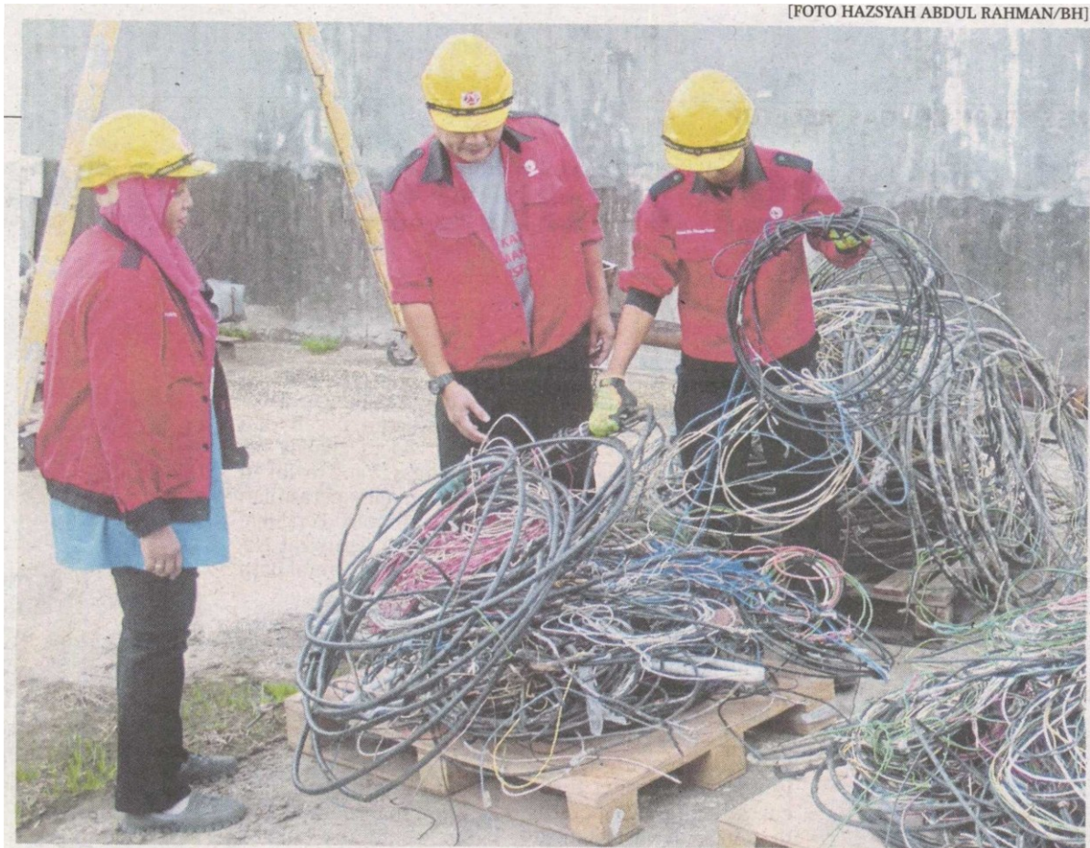
Kakitangan SESB memeriksa kabel yang dirampas di kawasan setinggan Batu Sapi dan Batu 3, Sandakan, semalam.
