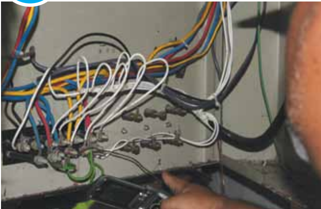
Gambar menunjukkan salah satu kaedah kecurian elektrik yang sedang diterangkan oleh pegawai serbu.
