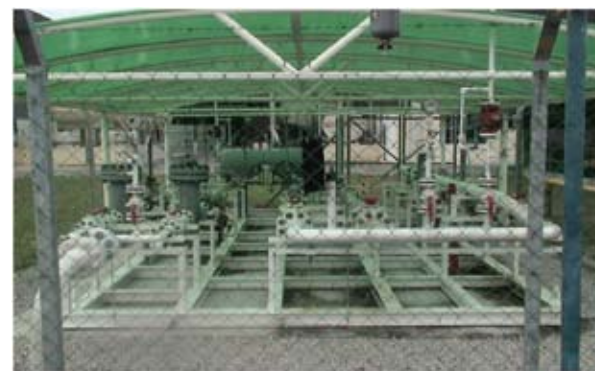
Pemasangan Gas Asli
