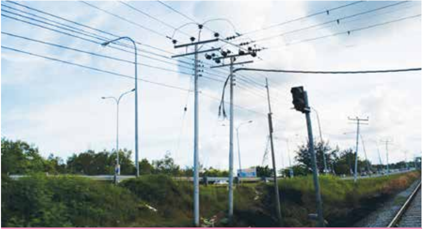
Lokasi Kejadian Section Pole , Talian 11kV Feeder S06 PMU Lok Kawi (Jalan Tombovo-Meruntum)
