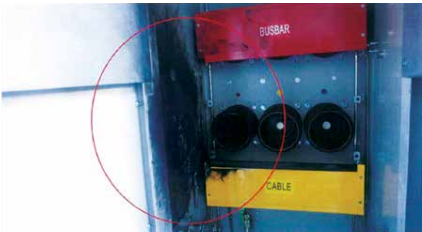
Bahagian Tepi Dalam VCB Kelihatan Kesan Percikan Arka Seperti di Dalam Bulatan
