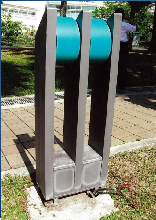
Lampu Bollard yang di sandar oleh mangsa. Badan lampu diperbuat daripada logam
