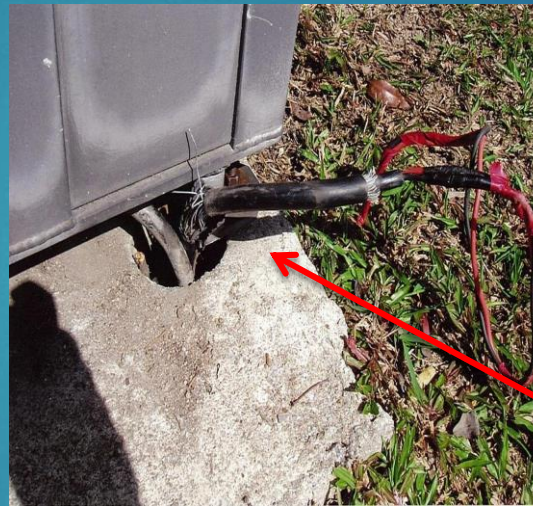
Kabel armoured pada bhg. bawah lampu bollard rosak.
