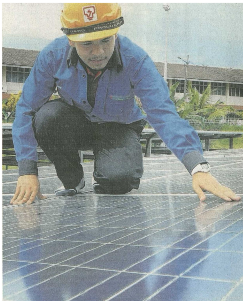
SEKOLAH Kebangsaan Ladang Mutiara, Kluang, Johor menerima bekalan elektrik selepas anak syarikat Tenaga Nasional Berhad (TNB), TNB Energy Services Sdn. Bhd.(TNBES) mendirikan Stesen Solar Hibrid (SSH) di sekolah itu.
