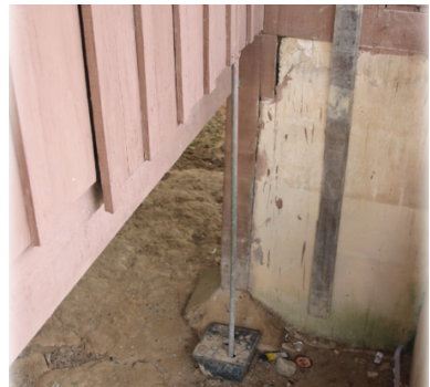
Gambar 11: Lokasi Paip Besi (Pembumian) yang Disentuh oleh Mangsa
