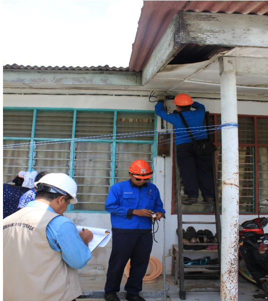
Gambar 77: Operasi Pemotongan Bekalan Sambungan Elektrik Haram Bersama ST Pulau Pinang, Kedah dan Perlis dan pihak TNB kawasan Sungai Petani.
